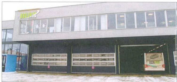
Fitness-Center: Im Untergeschoss sind die Busse von Aare Seeland mobil eingemietet.
